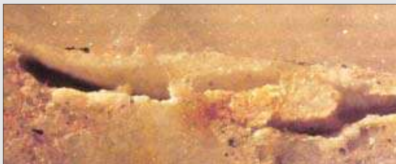
Revneblokade af \text{CaCO}_3 krystaller (Kalciumkarbonatudfældninger). Revnevide 0,2 mm. Foto af tyndslib.
