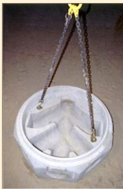
Eksempel på istøbte løftebolte i kombination med tilhørende løftegrej. Det giver en let og sikker håndtering.
