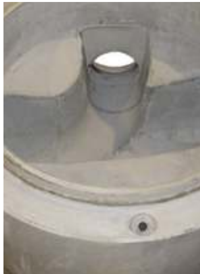
Rørmaterialets overflade har betydning for vandføringsevnen
