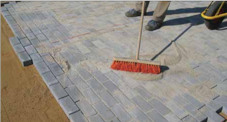
Figur 3.35. Fugegrus fejes i fugerne efterhånden som lægningen skrider frem.
