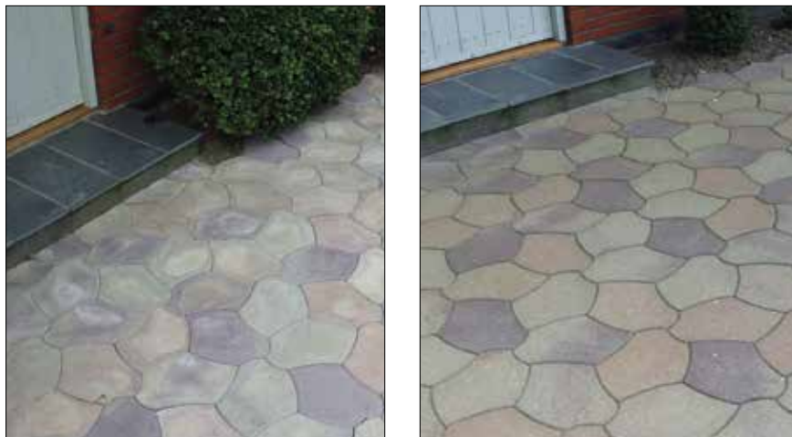
Figur 4.8. Til venstre ses almindelige kalkudfældninger på farvede sten. Billedet til højre viser samme belægning 2 år senere. Det ses, at kalkudfældningerne er væk, hvilket skyldes almindeligt slid samt vind og vejr generelt.
