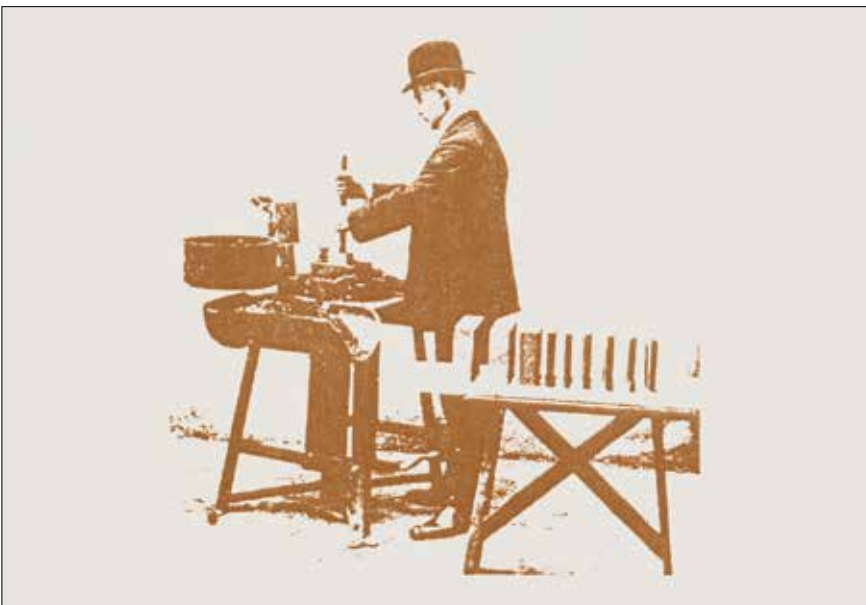
Figur 1.1. Billede fra 1920, hvor støbning af betonfliser var håndarbejde. Dette stillede store krav til den enkelte person, hvis kvaliteten skulle være god.
