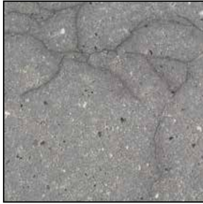
Figur 2.51. Eksempel på alkalikiselreaktioner, også kaldet "spindelvæv".
