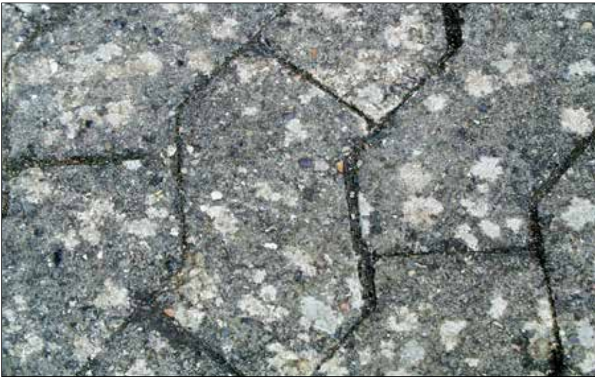
Figur 4.6. De hvide/grålige lavbevoksninger er sværere at fjerne end de grønne alger, men der findes midler der klarer dette. Her et kraftigt angreb på 25 år gamle betonsten.
