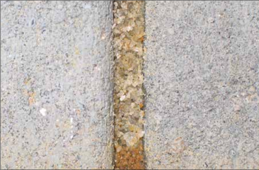
Figur 2.32. Foto af fuger forstørret 3 gange. For at få en tæt og stærk fuger er det vigtigt at gruset har en jævn kornfordeling i området 0-4 mm, at fugematerialet komprimeres af trafikken, og at de mindste hulrum fyldes op med diverse forvittringsprodukter.
