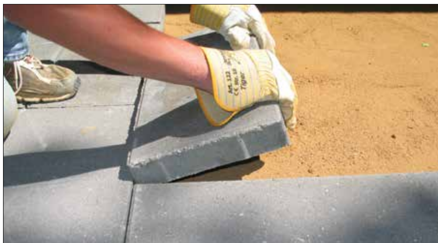
Figur 3.41. Fliserne lader man som betonsten, skride skråt ned for at opnå den korrekte fugebredde.
