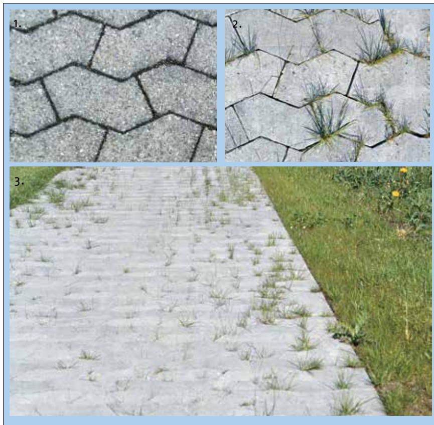
Figur 4.13. (1) Gamle fyldte fuger er meget modstandsdygtige overfor ukrudt, hvorimod ikke-fyldte fuger (2) giver gode vækstbetingelser for ukrudtet. (3) Endvidere er det vigtigt at lave en ordenlig kantafgrænsning, således at eksempelvis græssets rodnet ikke vokser ind i befæstelsen. Hovedproblemet her er dog ikke-fyldte fuger.
