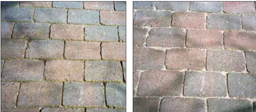
Figur 4.15. Belægninger efterfyldes med nyt fugegrus, straks der mangler noget. Det kan typisk være nødvendigt om foråret.
