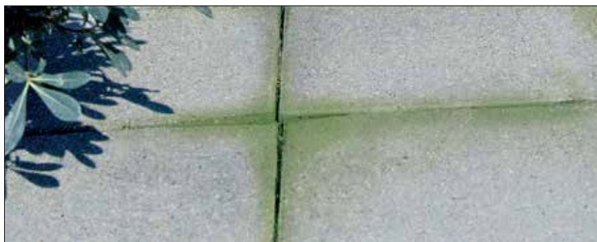
Figur 4.5. Den grønne alge er meget almindelig, og er rimelig let at fjerne. Algen ses på mange forskellige overflader, mure, biler, plankeværk, fliser, træer med videre.
