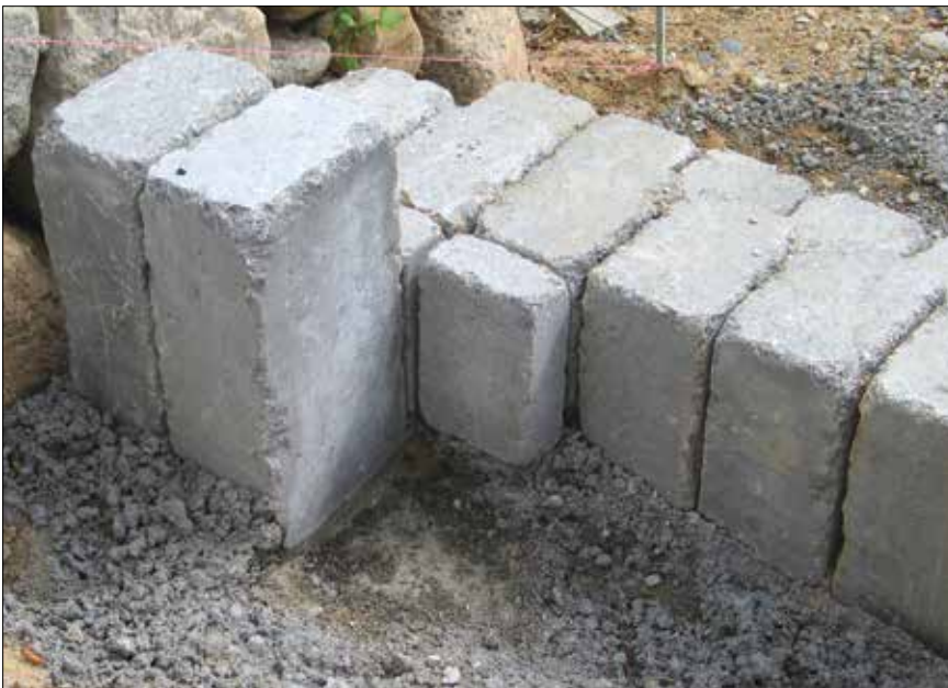
Figur 3.51. Sætning af trappe i jordfugtig beton.
