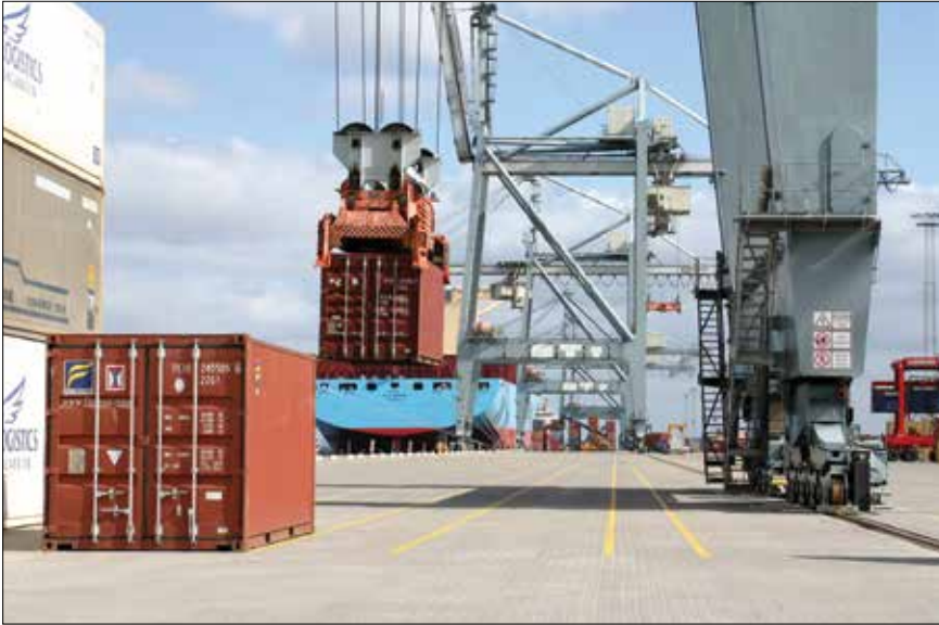
Figur 2.7. På containerpladser bliver betonstenenes gode tekniske egenskaber godt udnyttet. (Foto: Kirsten Bruun, Aarhus Havn)
