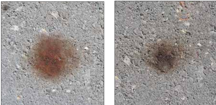
Figur 2.50. Forskellige former for jernudfældninger. Nogle typer forsvinder med tiden, andre gør ikke.
