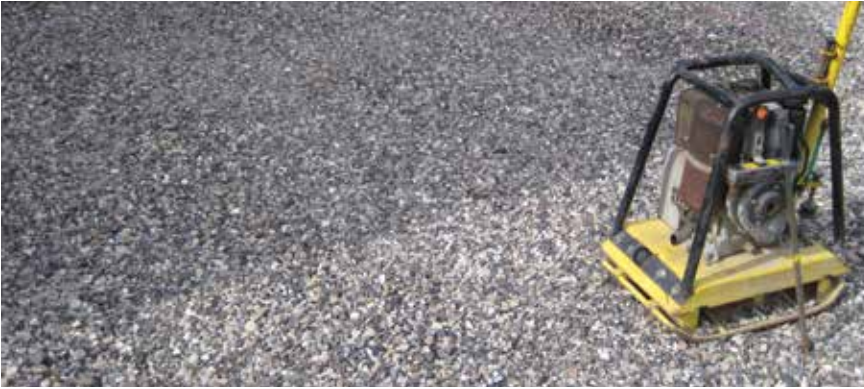
Figur 3.77. Vibrering af bærelag uden finstof og med ca. 30 % porevolumen.
