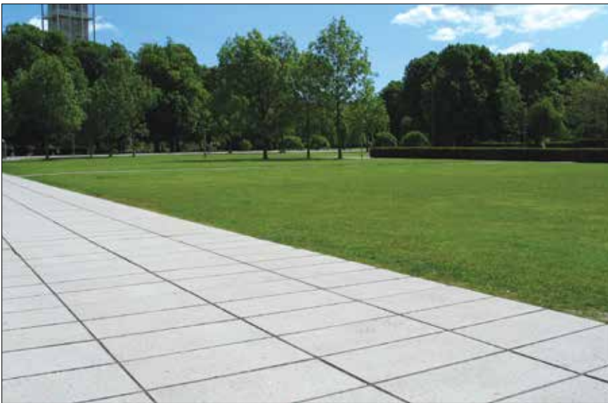
Figur 2.8. Betonsten og -fliser benyttes ofte til stier, gårdmiljøer, pladser i parkanlæg og lignende.
