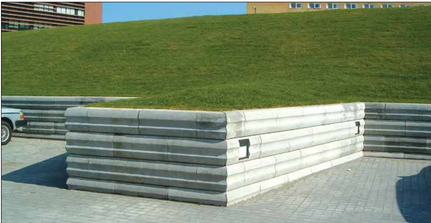
Figur 3.58. Støttemur. Det er vigtigt ved dimensioneringen at tage højde for belastningen oven for muren, f.eks. som her jordvolden.
