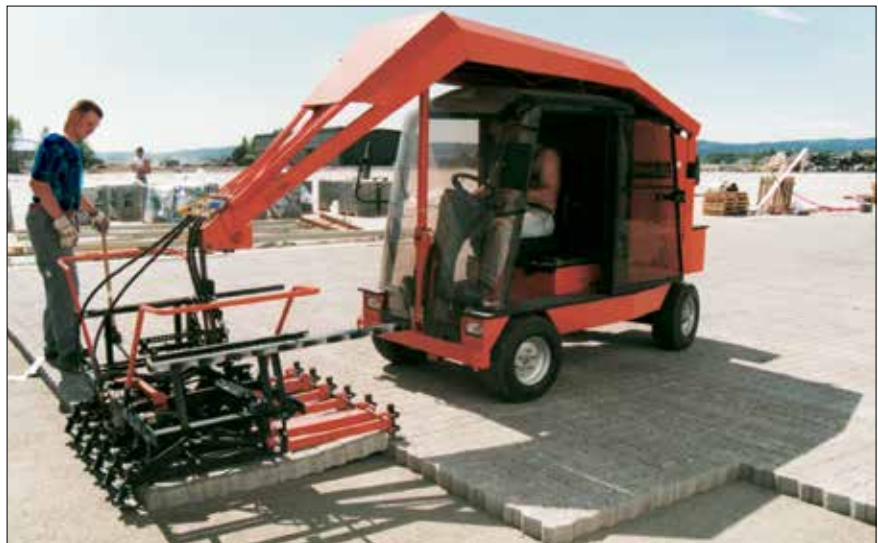
Figur 3.27. Maskinnedlægning af betonsten – hurtigt og effektivt.
