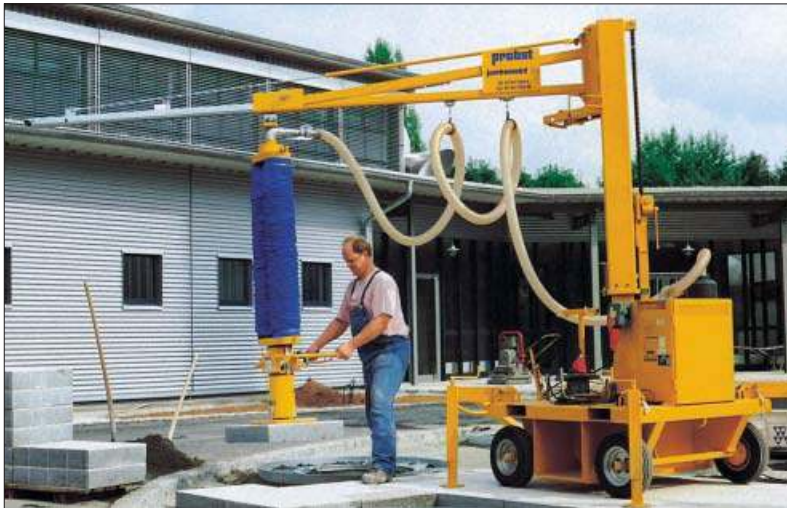
Brugen af vakuumløfteudstyr giver et godt arbejdsmiljø, men det medfører også en stor tidsmæssig besparelse ved større arealer.
