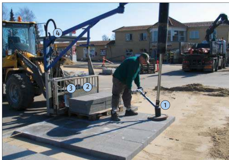
Vakuumløfteudstyret har flere dele der skal være fokus på: 1. Pakning ved mundstykke. 2. Luftfilter ved pumpe/turbine. 3. Pumpe/turbine, slitage. 4. Utætheder ved samlinger.
